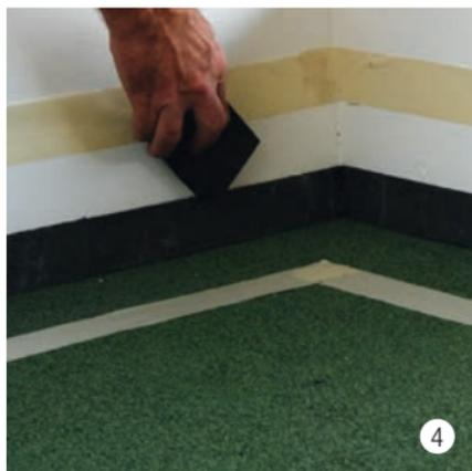
Irruvidire la superficie pulita con del materiale abrasivo adatto.
