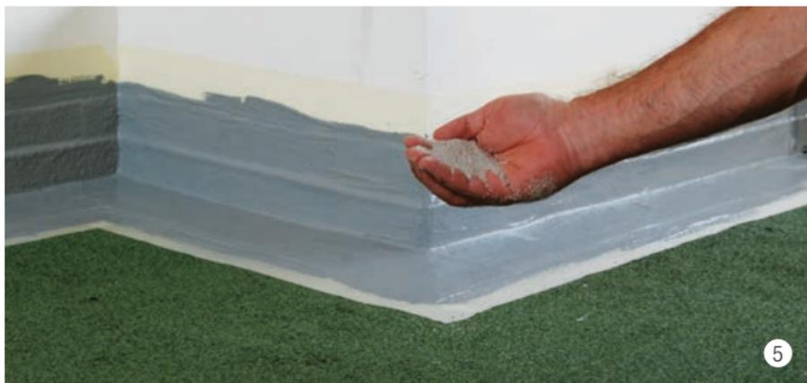
Applicare, se il caso lo richiede (strato di ancoraggio), tramite spandimento o spruzzatura, della sabbia di quarzo direttamente su BIKUCOAT-Alcalistop fresco.
