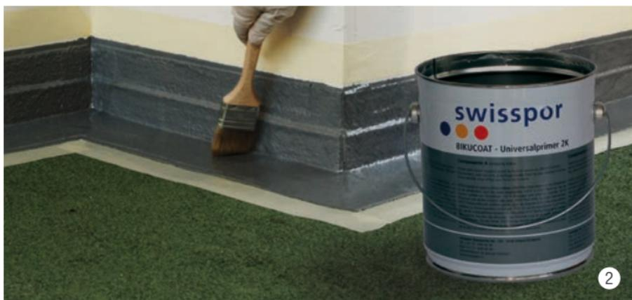
Applicare ca 200 g/m<sup>2</sup> di BIKUCOAT-Universalprimer 2K con il pennello o il rullo sulla guaina liquida esistente. Tempo di essiccazione ca. 30 - 60 minuti a seconda delle condizioni climatiche.
