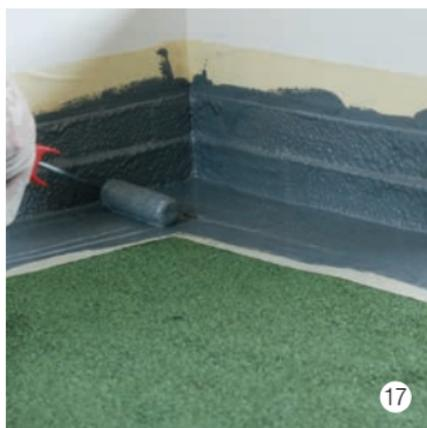
La struttura del feltro non deve essere visibile e la superficie superiore deve essere brillante.
