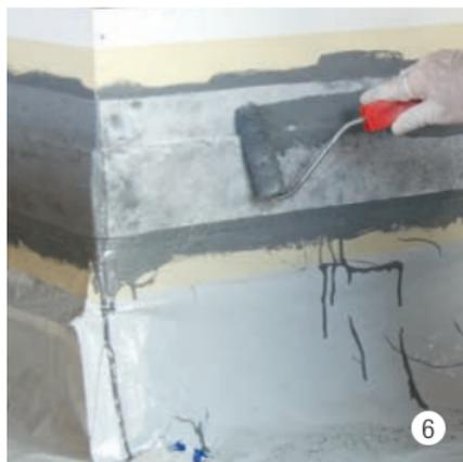
Impregnare la parte superiore del feltro in maniera di non più vedere la parte bianca.
