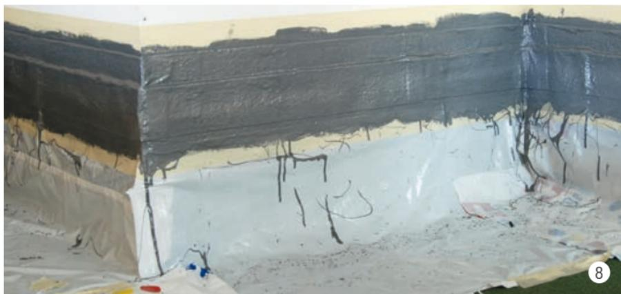
Applicare la 2a mano, min. 1 kg/m<sup>2</sup>. La struttura del feltro non deve più essere visibile e la superficie superiore deve essere brillante.
