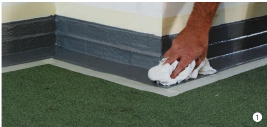
Pulire i raccordi nuovi o esistenti in BIKUCOAT-PUR (per nuovi raccordi eseguiti dopo ca. 48 ore dall'esecuzione). Incollare il nastro adesivo delimitando il bordo del raccordo.
