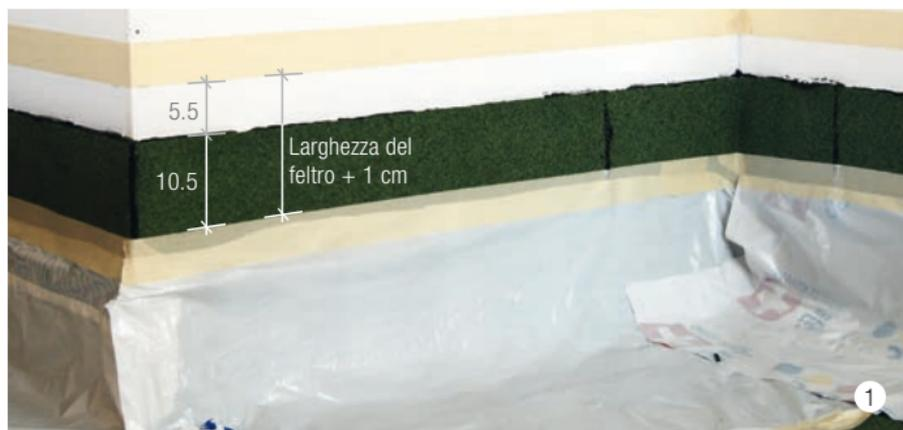
Incollare il nastro adesivo sull'impermeabilizzazione bituminosa a 10,5 - 11 cm.
