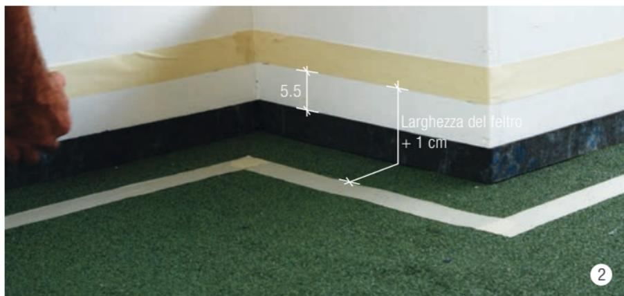
Incollare il nastro adesivo sul supporto a 5,5-6 cm di altezza nel risvolto.
