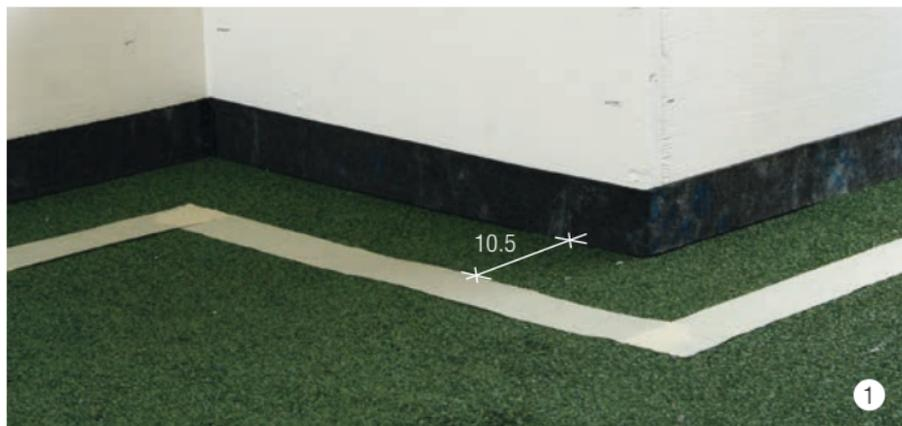
Incollare il nastro adesivo sull'impermeabilizzazione bituminosa a 10,5 cm dallo spigolo.
