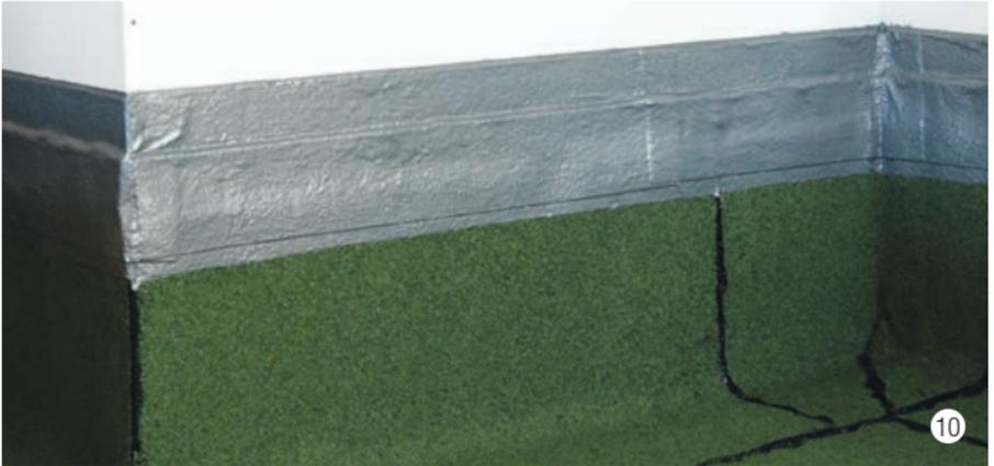
Dopo la messa in opera, resiste alla pioggia dopo ca. 2 ore a dipendenza delle temperature e dell'umidità. Completamente essicato dopo ca. 48 ore.
