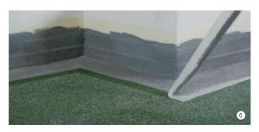
Retirer le ruban adhésif dès la fin de la mise en oeuvre. Enlever l'excédent de sable de quartz après le séchage de la couche.
