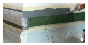
Appliquer la couche de base avec 2kg/m². Recouvrement du voile de 5 cm. Appliquer également la base entre le recouvrement du voile.
