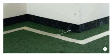
Coller le ruban adhésif sur l'étanchéité en bitume à 10.5-11 cm de l'angle.
