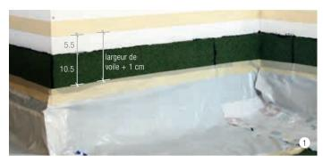
Coller le ruban adhésif sur l'étanchéité en lé bitumineux en laissant 10.5 - 11cm. Coller le ruban adhésif sur le support en laissant 5.5 - 6cm. La mesure entre les deux bandes adhésives correspond à la largeur de voile + 1 cm.
