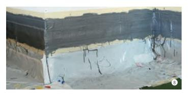
Appliquer la couche supérieure, min. 1kg/m². La structure du voile ne doit plus être visible, la partie supérieure doit être lisse et brillante.
