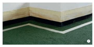
Temps de séchage environ 30 minutes en fonction des conditions climatiques (le Primer doit être sec et ne doit pas coller au toucher). Sur les bétons récents (moins de 6 mois) appliquer 2 couches de BIKUCOAT-Primer de façon à avoir une protection contre les alcalis. Laisser sécher le primer entre les deux applications.
