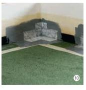
Positionner le voile des angles intérieurs et extérieurs, presser, éviter les poches d'air et les plis.
