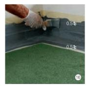
Appliquer la couche supérieure au min. de 1 kg/m². Les bords du voile doivent être recouverts des deux côtés de 0.5 cm
