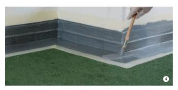
Appliquer env. 1kg/m<sup>2</sup> au moyen d'un pinceau ou d'un rouleau.
