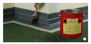
Appliquer le BIKUCOAT-Primer au pinceau ou au rouleau sur l'étanchéité liquide existante, env. 200 g/m². Temps de séchage d'environ 30 minutes, en fonction des conditions climatiques (ne doit pas coller au toucher).
