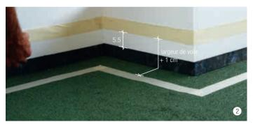
Coller le ruban adhésif sur le support à 5.5-6 cm au-dessus du relevé. La mesure entre les deux bandes de ruban adhésif correspond à la largeur de voile plus 1 cm.
