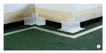
Découper les pièces dans le voile, ajuster les angles, positionner les angles préfabriqués et éventuellement les numéroter.
