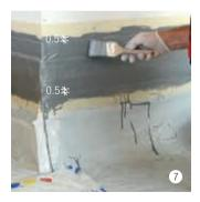
Eviter absolument toute inclusion d'air. Les bords du voile doivent être recouverts des deux côtés de 0.5 cm.
