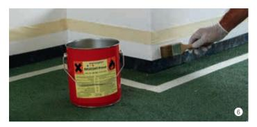
Appliquer le BIKUCOAT-Primer au pinceau ou au rouleau sur les parties à traiter. Utilisation:  $100-300 \text{ g/m}^2$ .
