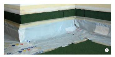
Appliquer le BIKUCOAT-Primer au pinceau ou au rouleau sur les parties à traiter, 100-300 g/m². Temps de séchage environ 30 minutes en fonction des conditions climatiques (le Primer doit être sec et ne doit pas coller au toucher).
