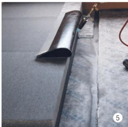
Ripiegare verso l'alto il telo della compartimentazione stagna, staccare la seconda striscia di foglio e attivare con la fiamma.
