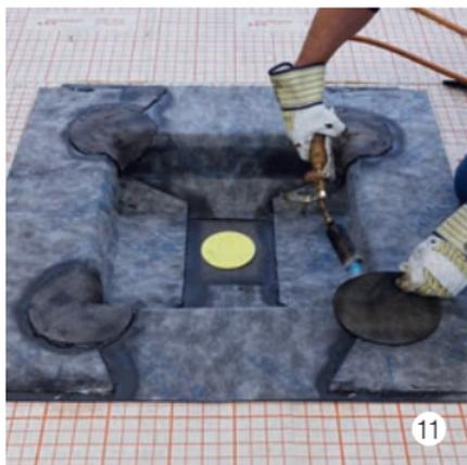
Saldare gli angoli superiori con rondelle di rinforzo per angoli. Segnare la quota per il raccordo.
