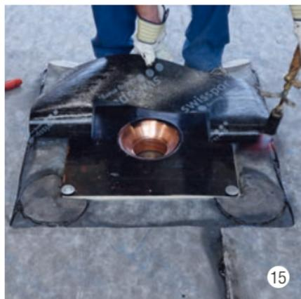
Saldare a filo il 1° telo alla bocchetta di scarico.
