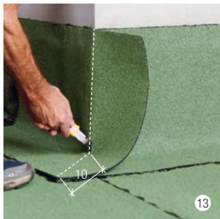
Saldare accuratamente il risvolto sul lato opposto e tagliare in senso verticale sullo spigolo. Sovrapposizione minima di 10 cm nel punto di raccordo con la superficie del 2° telo.
