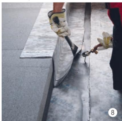
Saldare il raccordo della compartimentazione stagna con la barriera vapore.
