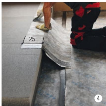
Incollare 25 cm sulla superficie dell'isolamento e comprimere accuratamente.
