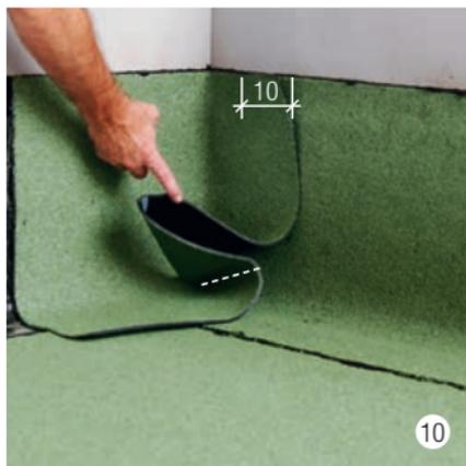
Sovrapposizione min. 10 cm sul 2° telo del risvolto. Formare la piegatura.
