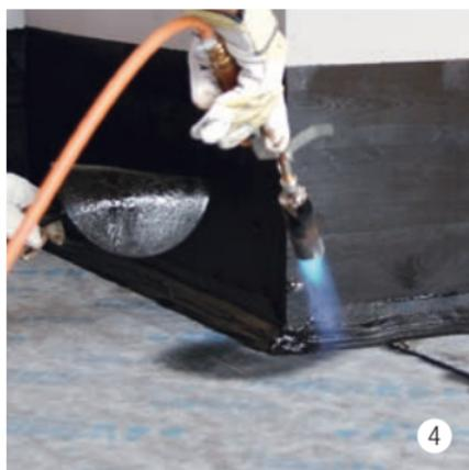
Riscaldare la superficie del supporto da impermeabilizzare e il triangolino.
