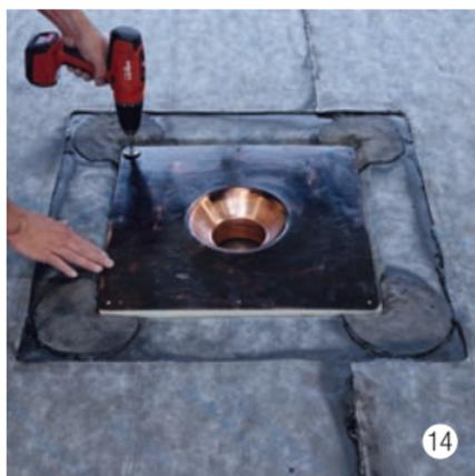
Inserire la bocchetta di scarico, fissare con quattro viti.
