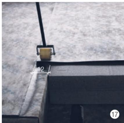
Posare il 1° telo dell'impermeabilizzazione con una sovrapposizione laterale di 12 cm sulla compartimentazione stagna. Staccare il foglio nella zona di sovrapposizione e comprimere.
