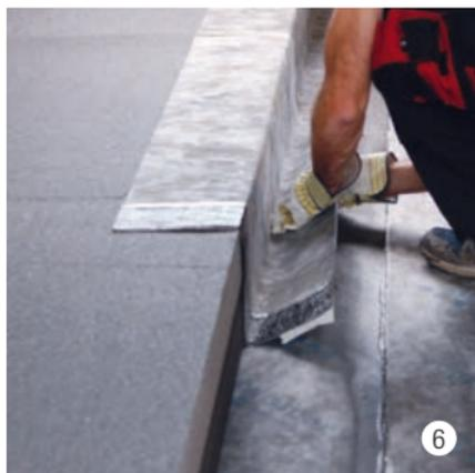
Comprimere il telo della compartimentazione stagna fino sopra lo spigolo nella superficie della barriera vapore senza lasciare spazi vuoti.
