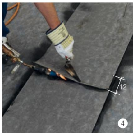
Saldare con poca fiamma la sovrapposizione del giunto di testa. Rispettare la sovrapposizione di 12 cm (2 cm alluminio + 10 cm giunto saldato).
