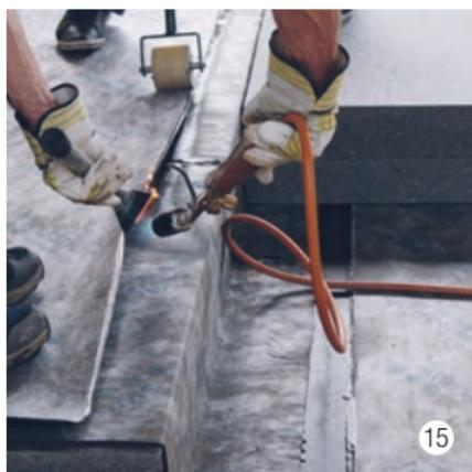
Saldare accuratamente la parte anteriore della sovrapposizione con la compartimentazione stagna.
