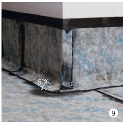
Saldare accuratamente risolto e sovrapposizione. Sovrapposizione minima di 5 cm nel punto di raccordo con la superficie.
