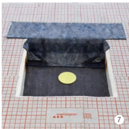
Saldare il telo della compartimentazione stagna con la barriera vapore e saldare in orizzontale la piegatura.
