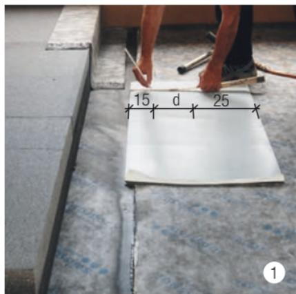
Ritagliare il telo della compartimentazione stagna. La misura si calcola dallo spessore dell'isolamento =  $d$  e  $15 + 25$  cm di parte sovrapposta.
