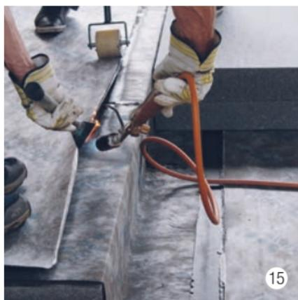
Souder proprement la partie extérieure avec le recouvrement latéral.
