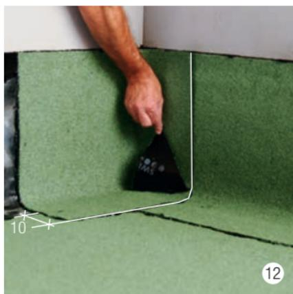
Recouvrir le relevé de 10 cm sans laisser de bulles d'air et souder proprement. Incruste la paillette sur la 2ème couche en chauffant et en tapotant la zone de soudure avec une spatule pour faciliter la soudure.
