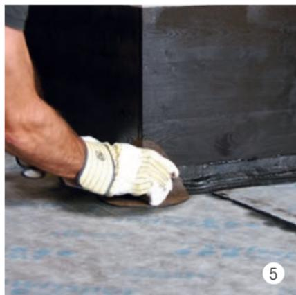
Positionner le renfort d'angle autour de l'angle en le dégorgéant.
