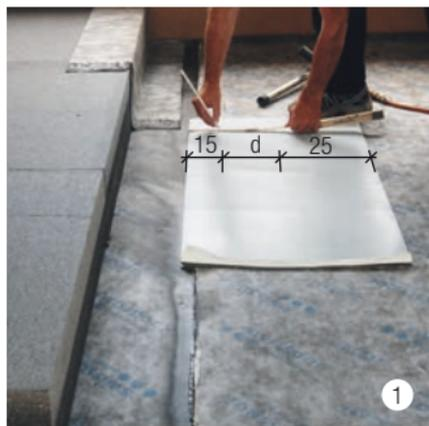
Découper le lé d'étanchéité. La dimension de coupe dépend de l'épaisseur de l'isolation =  $d$  à additionner au recouvrement, soit  $15 + 25$  cm.
