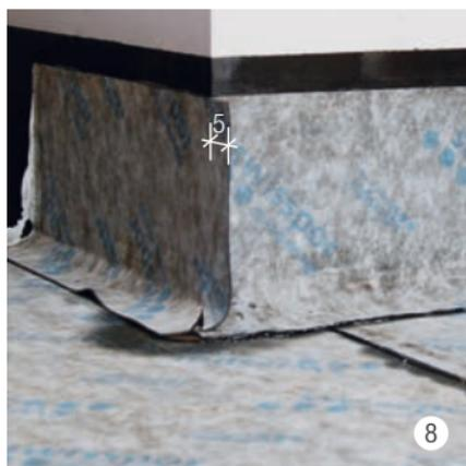
Poser le lé d'étanchéité sur l'autre côté de l'angle en laissant dépasser 5 cm et souder proprement des deux côtés.
