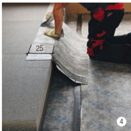
Coller la partie du lé de 25 cm sur la surface supérieure de l'isolation thermique et presser.
