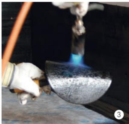
Chauffer la rondelle de renfort d'angle swissporBIKUTEC EJ3.5 flam.
