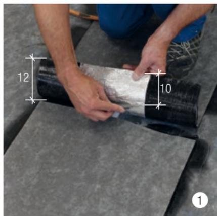
Couper le swissporBIKUTOP LL DILA WF et exécuter un recouvrement de 12 cm. Couper proprement la feuille d'aluminium à 10 cm.
