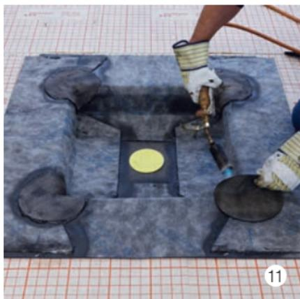
Souder les angles supérieurs avec des rondelles de renfort d'angle. Dessiner les dimensions pour le raccordement.
