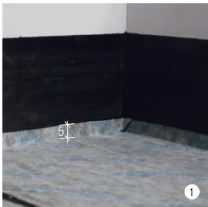
Relever le premier lé de 5 cm, couper dans l'angle en diagonale et souder sans laisser de bulles d'air entre le support et le lé.
