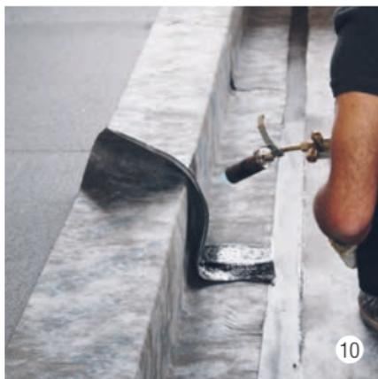
Chauffer et souder le recouvrement.
