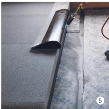
Replier le lé sur le haut, retirer la deuxième partie du film et activer la sous-face au chalumeau.
