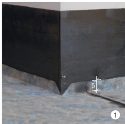
Relever le lé de 5 cm, couper dans l'angle et souder sans laisser de bulles d'air entre le support et le lé.
