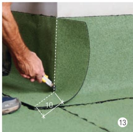
Souder le deuxième relevé sur le côté opposé et couper le débord verticalement sur l'angle. Le recouvrement sur le raccord de la deuxième couche doit dépasser de 10 cm.
