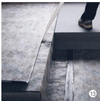
Retirer le film sur le recouvrement.
