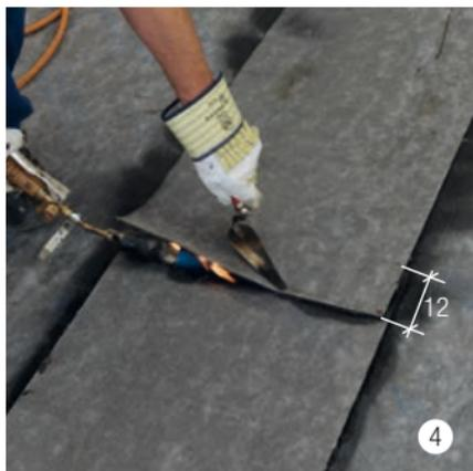
Souder l'extrémité du recouvrement. Maintenir un recouvrement de 12 cm (2 cm d'aluminium + 10 cm de soudure).
