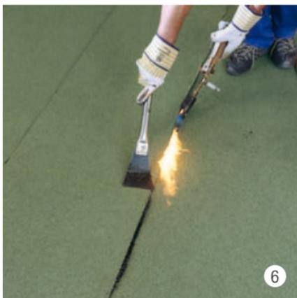
Souder la bande d'étanchéité de l'autre côté.
