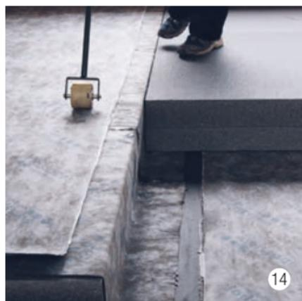
Presser la partie intérieure autocollante du recouvrement.
