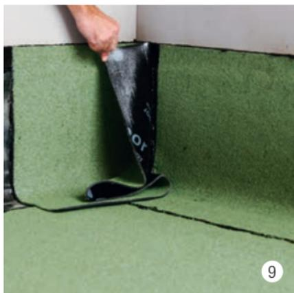
Souder proprement le relevé opposé et le replier sur l'angle.
