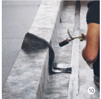
Flammfolie abflämmen und verschweißen.
