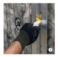
Vento Clip 0° gerade, gelb, befestigen mit einer viertel Drehbewegung im Vento Hutprofil-Clip oder Z-Profil-Clip.
