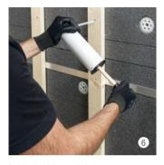
Bohrloch reinigen mit Ausblaspumpe.
