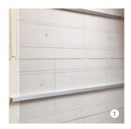
Vento Aluwinkel 29/40 satt in den horizontalen, dafür gefertigten Schlitz der Dämmung drücken (40 mm Schenkel in Dämmung).
