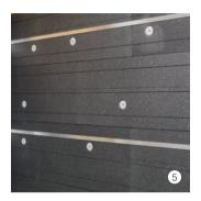
Vento Aluwinkel 29/40 satt in den horizontal dafür gefertigten Schlitz der Dämmung drücken (40 mm Schenkel in die Dämmung).
