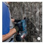
Die verlegte Dämmung mit dem Untergrund mechanisch befestigen. Mit Mehrzweckbohrer / Hammerbohrer je nach Untergrund bohren im Durchmesser von 8 mm.
