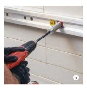
Vento Bohrlehre 15° horizontal, rot, mit viertel Drehbewegung in Vento Aluwinkel-Clip setzen. Bohren mit Mehrzweck- / Hammerbohrer, ausblasen.
