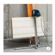
Exaktes Zuschneiden der Dämmplatten mit einem geeigneten Schneidgerät.
