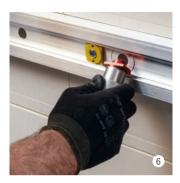
Vento Clip 15° horizontal, rot, mit viertel Drehbewegung in Vento Aluwinkel-Clip setzen.
