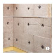
Vento Aluwinkel 29/40 satt in den horizontalen Plattenstoss drücken (40 mm Schenkel in der Dämmung).
