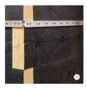
Vento Aluwinkel-Clip satt in den horizontalen Plattenstoss der Dämmung drücken.
