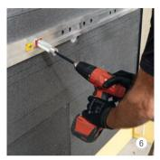
Bohren mit Mehrzweckbohrer / Hammerbohrer je nach Untergrund, im Durchmesser von 10 mm und einer min. Tiefe von 110 mm. Bohrloch ausblasen.
