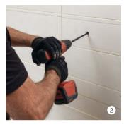
Die verlegte Dämmung mit dem Untergrund mechanisch befestigen, dazu Untergrund mit Mehrzweckbohrer / Hammerbohrer je nach Untergrund bohren im Durchmesser von 8 mm.
