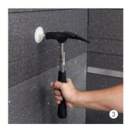
Dämmplatte mit Dämmstoffhalter ejotherm fest mit dem Untergrund verdübeln. Schnittkanten ohne Nut und Kamm immer mit swisspor Montagekleber verkleben.
