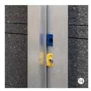
Vento Clip 15° vertikal, blau, mit viertel Drehbewegung in Vento Hutprofil-Clip oder Vento Z-Profil-Clip setzen.
