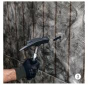
Dämmstoffhalter DH Typ Schaft mit Untergrund bis zum Anschlag fest verdübeln.
