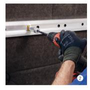
Vento Bohrlehre 0° gerade, gelb, befestigen mit einer viertel Drehbewegung im Vento Aluwinkel-Clip. Bohren mit Mehrzweck- / Hammerbohrer, ausblasen.
