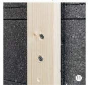
Verschraubung in der Vertikalen etwa um 5 mm versetzt anordnen (Spalten des Holzes) und in einem horizontalen Abstand von 70 mm
