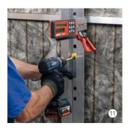
Mittels Rotationslaser und Laserempfänger wird die Unterkonstruktion ausgerichtet und fest mit dem Untergrund verschraubt. Kein Verschieben mehr möglich!
