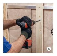
Mehrzweckbohrer / Hammerbohrer je nach Untergrund, im Durchmesser von 10 mm und einer min. Tiefe von 110 mm. Bohrloch reinigen mit Ausblaspumpe.
