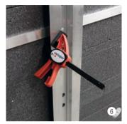
Vento Hutprofil-Clip oder Z-Profil-Clip vertikal ausrichten und festklemmen zur Vorbereitung für das Verschrauben mit dem vertikalen Vento Aluwinkel 29/40.
