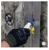
Vento Bohrlehre 15° vertikal, blau, befestigen mit einer viertel Drehung im Vento Hutprofil-Clip oder Vento Z-Profil-Clip.
