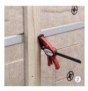
Lattung vertikal ausrichten und festklemmen zur Vorbereitung für das Verschrauben mit dem horizontalen Vento Aluwinkel 29/40.
