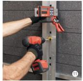
Mittels Rotationslaser und Laserempfänger wird die Unterkonstruktion ausgerichtet und fest mit dem Untergrund verschraubt. Kein Verschieben mehr möglich!
