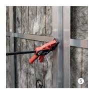
Vento Aluwinkel 29/40 satt in den horizontalen Plattenstoss der Dämmung drücken. Vento Hutprofil-Clip oder Z-Profil-Clip vertikal ausrichten und festklemmen.
