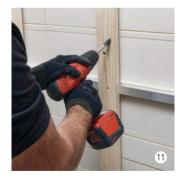
Vento Distanzschraube fest mit dem Untergrund verschrauben (Fachwerkverschraubung).
