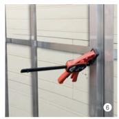
Vento Hutprofil-Clip oder Z-Profil-Clip vertikal ausrichten und festklemmen zur Vorbereitung für das Verschrauben mit dem horizontalen Vento Aluwinkel 29/40.
