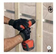
Lattung mit dem Vento Aluwinkel 29/40 fest verschrauben mit der Selbstbohrschraube Holz-Alu 5 x 50 mm.
