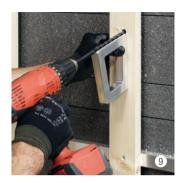
Mittels Vento Bohrlehre Untergrund mit 15° nach oben bohren mit Mehrzweckbohrer / Hammerbohrer je nach Untergrund, im Durchmesser von 10 mm. ausblasen.
