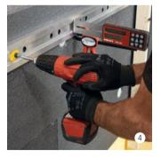
Vento Clip 0° gerade, gelb, mit viertel Drehbewegung in Vento Aluwinkel-Clip setzen, die Vento Distanzschraube positionieren, Profil ausrichten und fest verschrauben
