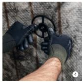
Teller mit leichtem Druck auf Schaft stecken, bis die Dämmung sauber festklemmt (auch zweilagige Verlegung möglich).
