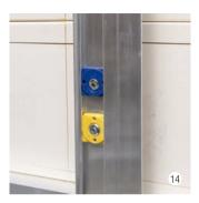
Gesamte Unterkonstruktion fest mit dem Untergrund verschraubt (Fachwerkverschraubung).
