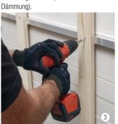
Lattung mit dem Vento Aluwinkel 29/40 fest miteinander verschrauben mit der Selbstbohrschraube Holz-Alu 5 x 50 mm. Je nach Bedarf 1 bis 2 Verschraubungen.
