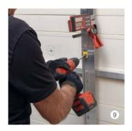
Vento Clip 0° gerade, gelb, mit viertel Drehbewegung in Vento Aluwinkel-Clip setzen. Vento Distanzschraube bis zum Anschlagpunkt positionieren, ausrichten, fest verschrauben.
