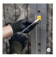
Vento Distanzschraube bis zum Anschlagpunkt positionieren und mit dem Untergrund vorverschrauben.
