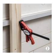
Lattung vertikal ausrichten und festklemmen zur Vorbereitung für das Verschrauben mit dem horizontalen Vento Aluwinkel 29/40.
