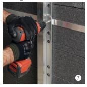
Die beiden Vento Profile miteinander fest verschrauben mit der Selbstbohrschraube Alu-Alu 4.8 x 25 mm (Materialstärke bis max. 4 mm).
