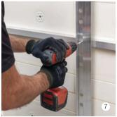
Die beiden Vento Profile fest verschrauben mit der Selbstbohrschraube Alu-Alu 4.8 x 25 mm (Materialstärke bis max. 4 mm).
