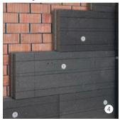
Dämmstoffplatten immer im Versatz (ohne Kreuzstösse) von unten nach oben verlegen. Es ist auf eine hohlraumfreie Auflage auf dem Untergrund zu achten.
