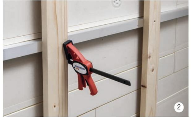
Vertikal Unterkonstruktion ausrichten und festklemmen.
