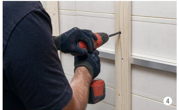
Untergrund für die Vento Distanzschraube vorbohren.
