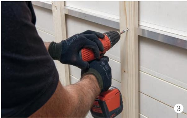
Unterkonstruktion wird mit dem Aluwinkel fest verschraubt.
