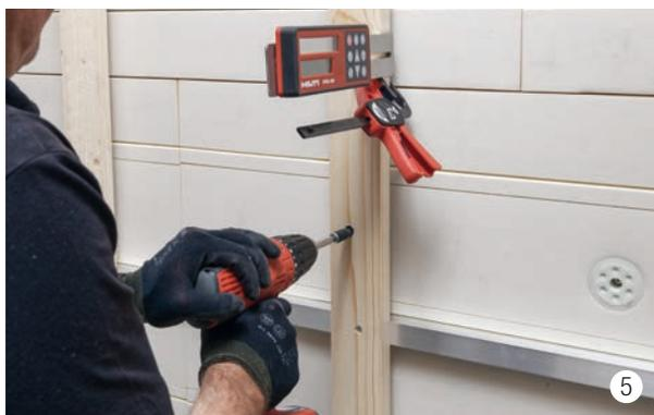
Unterkonstruktion wird mit einem z.B. Rotationslaser ausgerichtet und fest verschraubt mit der Vento Distanzschraube im Untergrund.
