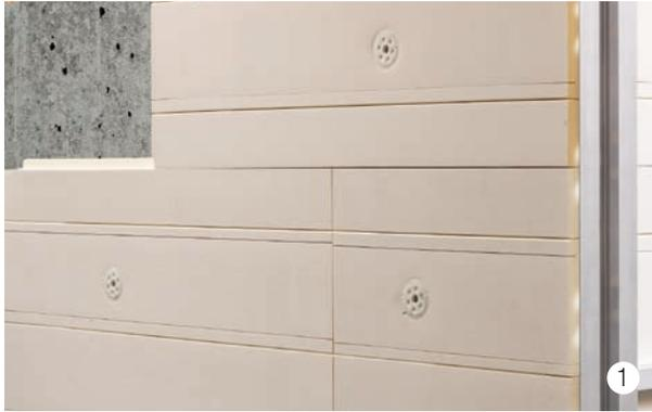
Die Verlegung der Wärmedämmplatten erfolgt im Versatz (ohne Kreuzstöße) von unten nach oben.
