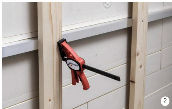
Allineare la sottostruttura verticale e bloccare con un morsetto.
