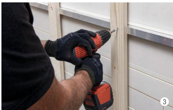
Fissare la sottostruttura all'angolo in alluminio tramite vite.
