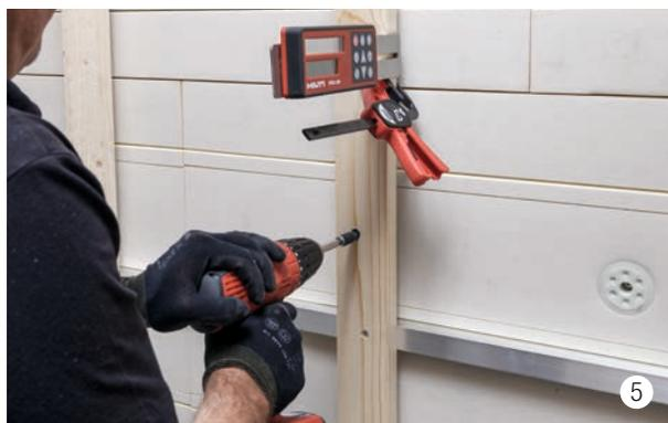
Allineare la sottostruttura, per es. con un laser rotativo, e fissarla al supporto con una vite distanziale Vento.
