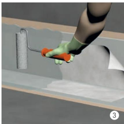
Das zugeschnittene Vlies in die frische Einbettschicht einlegen und mit dem Roller blasenfrei einarbeiten. Nahtüberlappung Vlies mindestens 5 cm.
