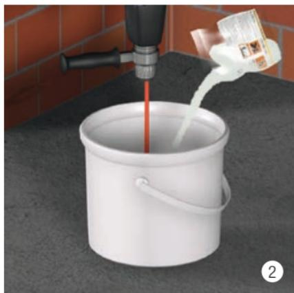
Katalysatormenge laut Mischtablette Seite 10 bei langsam laufendem Rührwerk zugeben und 2 min. lang mischen.
