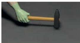
Untergrund mittels Hammer auf Hohlstellen untersuchen. Die Stellen kennzeichnen.
