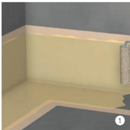
Passende Grundierung (gemäss UG-Tabelle S. 12–13) mittels Roller oder Pinsel auftragen.
