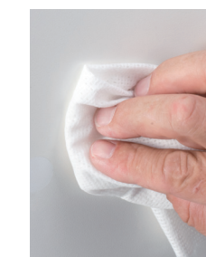
6. KLEBERRESTE MIT SAUBEREN FEUCHTEN TUCH ENTFERNEN
