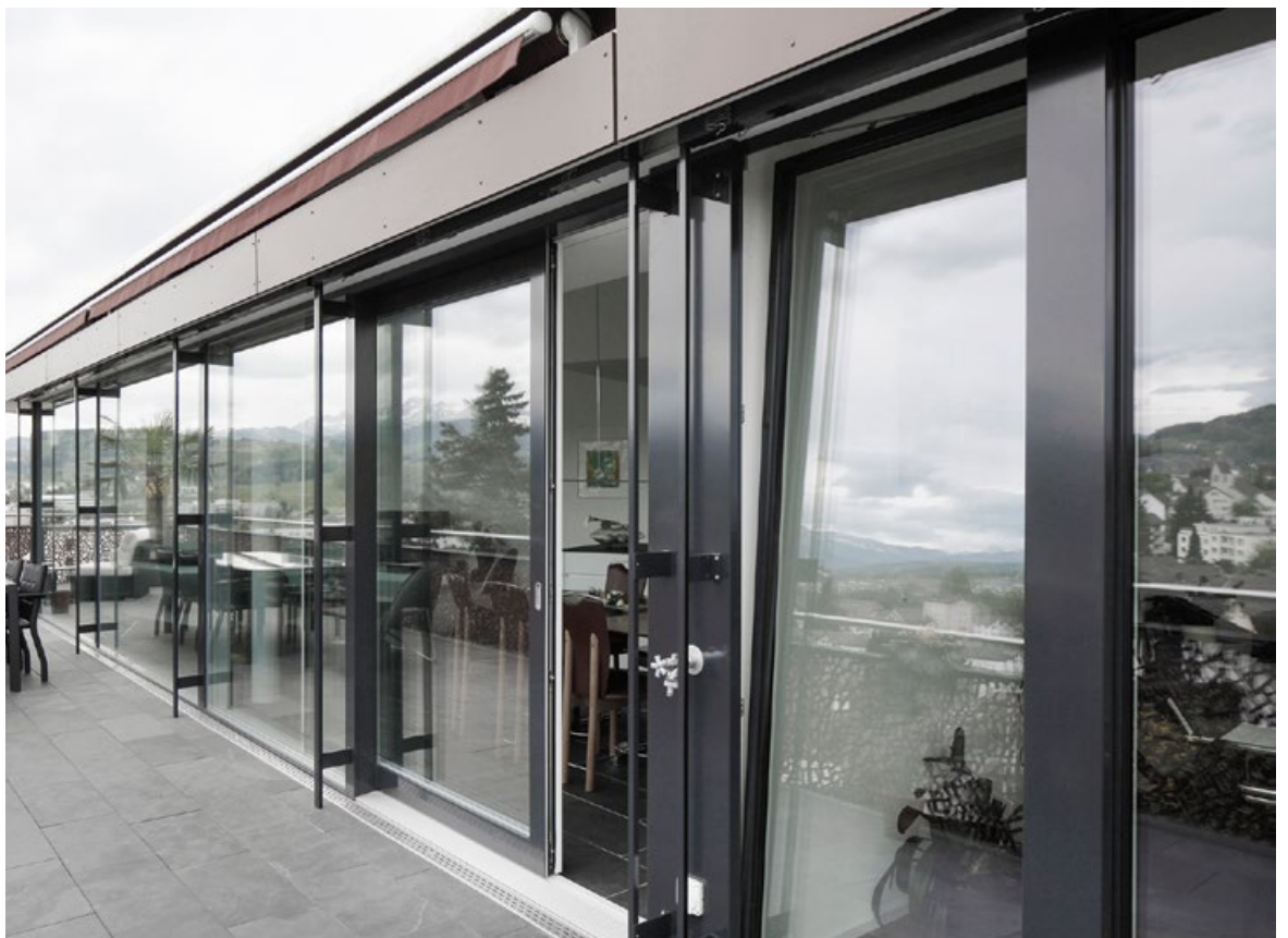
Immeuble résidentiel Abtwil (Suisse)
