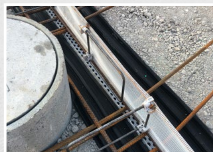
Dank des Klapp-Mechanismus kann Hindernissen ausgewichen werden
