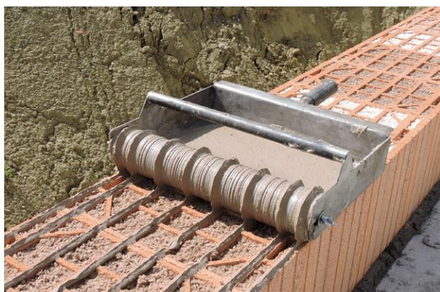
Beim klassischen Verfahren wird der **Dünnbettmörtel** Capofisso mit einer Mörtelrolle «in Streifen» aufgetragen.
