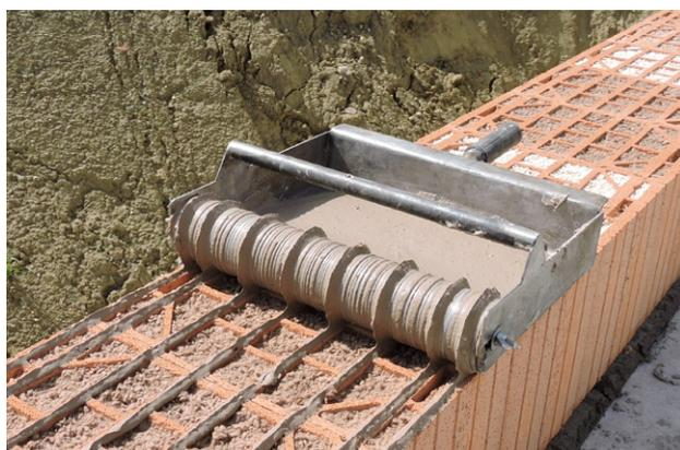
Le procédé classique consiste à appliquer le **mortier à joint mince** Capofisso «en ligne» à l'aide d'un rouleau applicateur.
