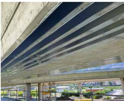
Renforcement passif à la flexion avec des S&P C-Laminates collées en sous-face
