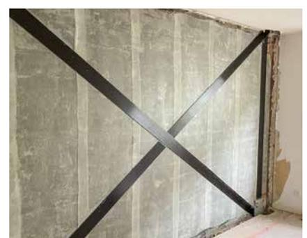
Renforcement sismique avec S&P G-Sheet et S&P C-Laminates
