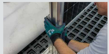
8 Kabelkanal an Ständer und oberer Querschiene einklicken
