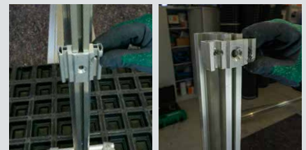
5 Modulkanten mit Klemmen am Ständer definieren und fixieren
