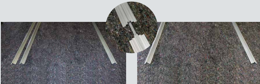
1 Auslegen der Schienen nach Plan mit gesteckten Schienenverbinder. Zwei Schienen, wo die statischen Anforderungen höher liegen.
