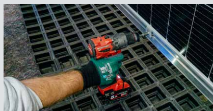
7 Modul einlegen und mit Modulklemmen fixieren
