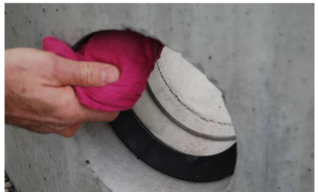
Bild 28: Reinigen des Dichtringes
