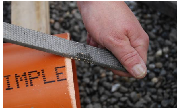
Bild 27: Anschleifen des Rohres
