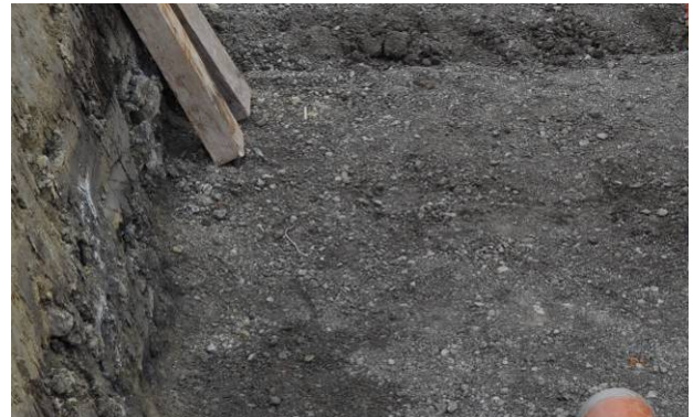
Bild 23: Vorbereitete Grabensohle
