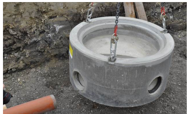
Bild 24: Herablassen des Schachtbodens
