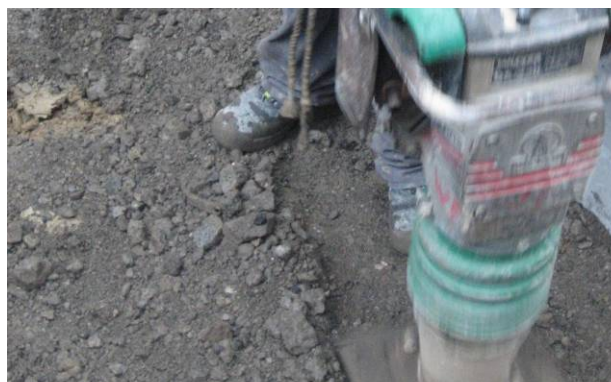
Bild 35: Lagenweises Einbringen und Verdichten des Auffüllmaterials
