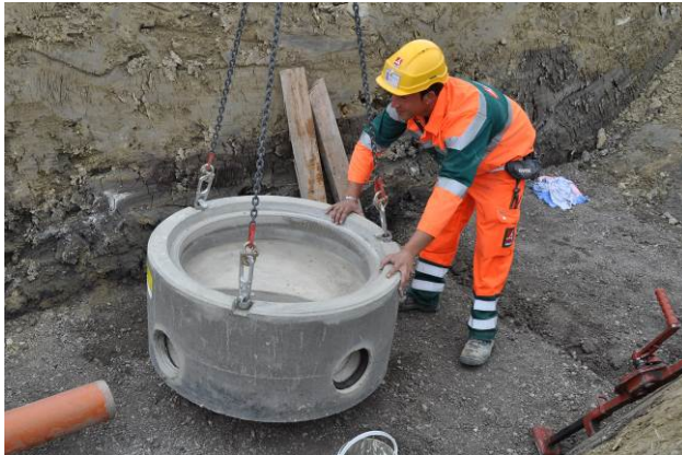
Bild 19: Interner Baustellentransport mit geeignetem Hilfsmittel
