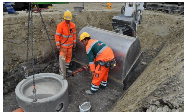
Bild 25: Zusammenzug mit Stockwinde
