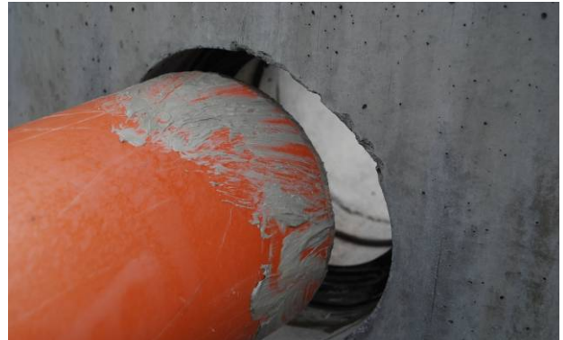
Bild 30: Zentrisches Ansetzen des Kunststoffrohres
