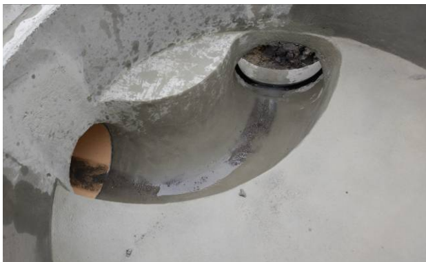
Bild 2: CRENO Normschachtboden gefräst
