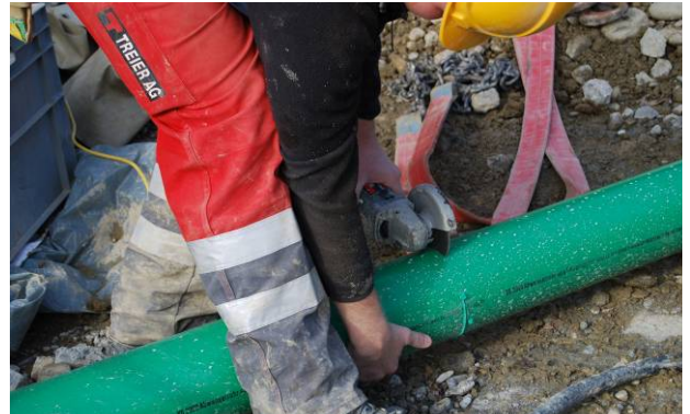
Bild 26: Ablängen des Kunststoffrohres
