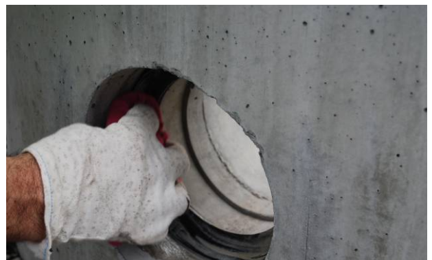
Bild 29: Dichtring mit geeignetem Gleitmittel einschmieren
