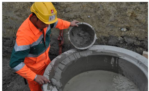
Bild 32: Aufbringen einer Frischmörtelschicht
