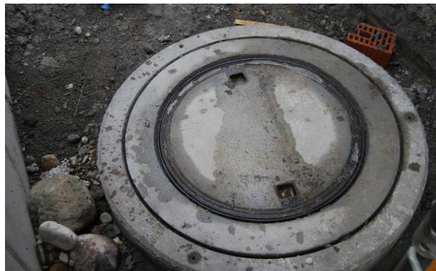
Bild 34: Aufsetzen eines Betondeckels mit Kontrollöffnung bei zu geringer Schachthöhe
