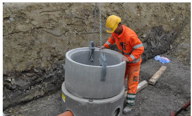
Bild 33: Versetzen eines Betonrohres mit Falzmuffen mit geeignetem Hebewerkzeug
