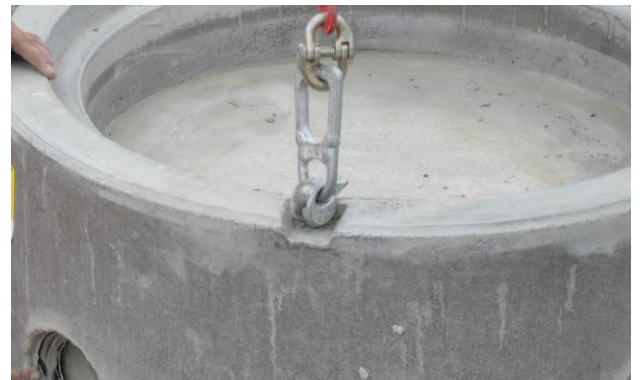
Bild 18: Werkseitig eingebaute Kugelkopftraganker mit Kupplung
