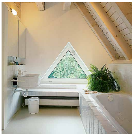
Bardage et chevrons traités avec une lasure blanche
