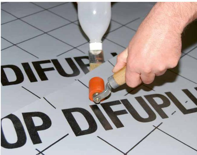
Froid – avec solution liquide de soudage
