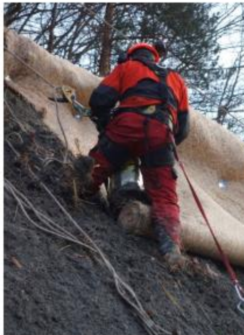
Howolis Erosionsschutzvlies aus Holzwolle (Lindner Suisse GmbH)
