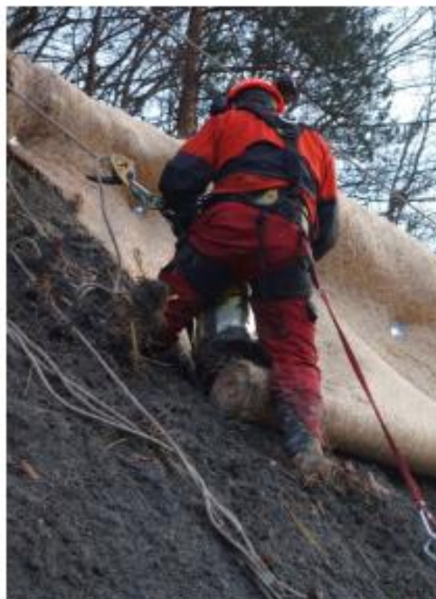
Howolis Erosionsschutzvlies aus Holzwolle (Lindner Suisse GmbH)
