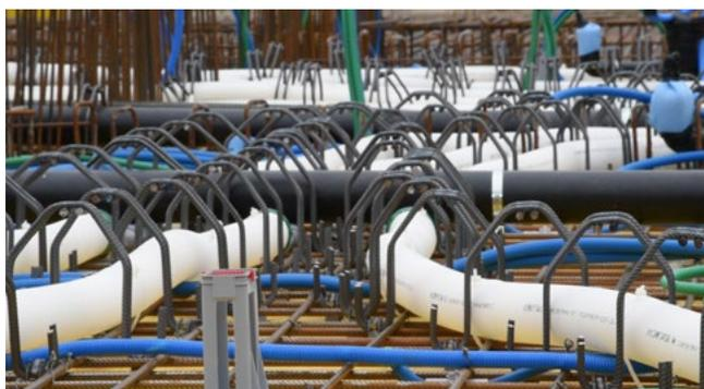
Il sistema di armatura a taglio FIROLA® è stato testato in cantiere con ottimi risultati. Il riscontro dell'impresa di costruzione e del progettista è stato molto positivo in virtù dell'elevata flessibilità, nonché della semplicità e della rapidità di montaggio.
