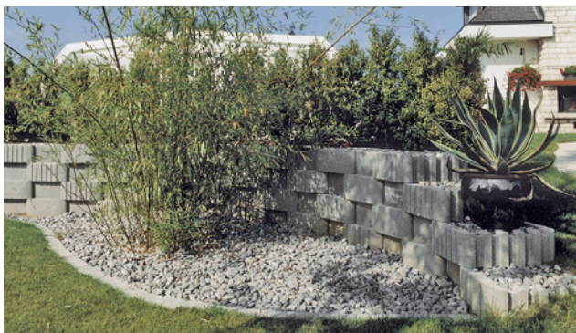
Application stabilisation de pentes
