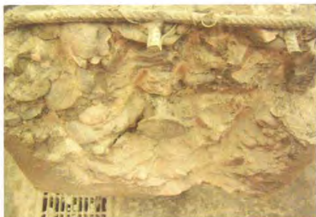
Freigelegte Endverankerung
