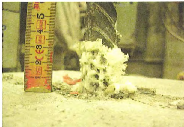
Prüfkörper 8506: Auszug aus Betonelement
