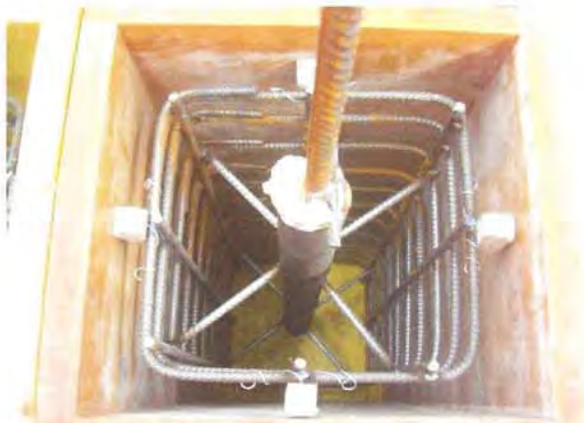
Eingebauter Armierungskorb mit Zugstange
