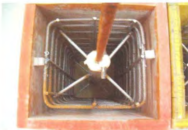
Eingebauter Armierungskorb mit Zugstange
