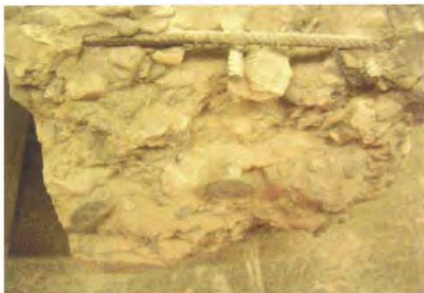
Freigelegte Endverankerung
