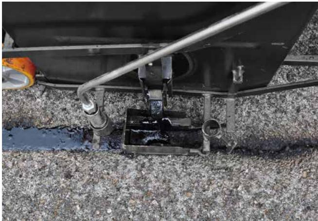
Remplissage des fissures avec du bitume chaud
