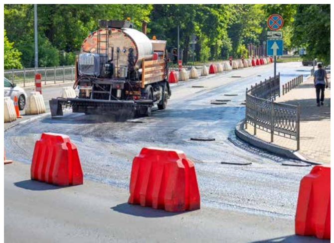
Anspritzen der Bitumenemulsion
