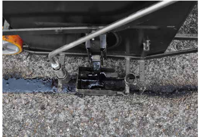
Rissverguss mit heissem Bitumen
