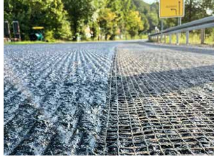
Gefräste Oberflächen
