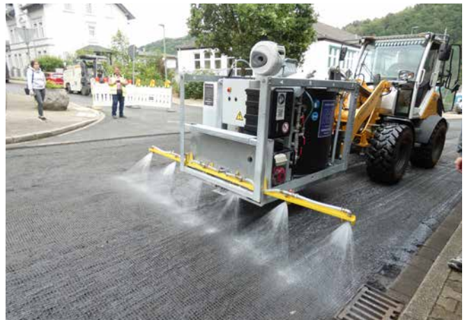
Aufbringen von Kalkhydratsuspension
