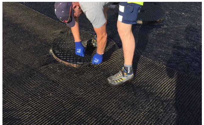
Die Gitter können leicht um Schächte herum ausgeschnitten werden
