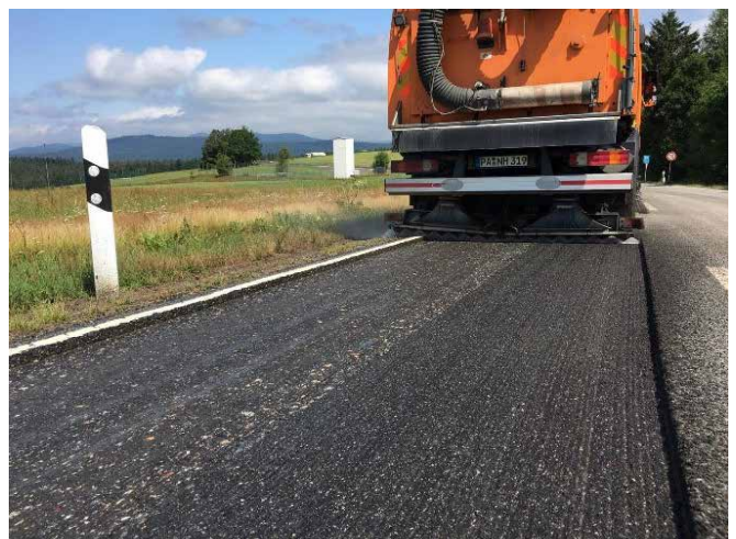
Reinigen der Oberfläche
