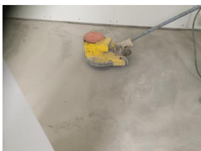
ponçage du substrat
