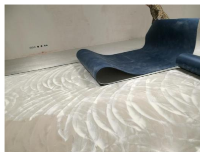
placement du tapis dans l'adhésif
