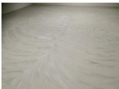
substrat avec mastic d'égalisation
