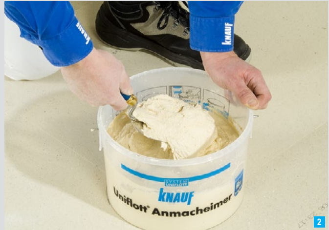
Anrühren von Knauf Uniflott mit der Kelle
