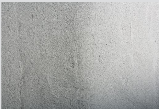
Erhöht gespachtelte Fuge bei viel Streiflicht
