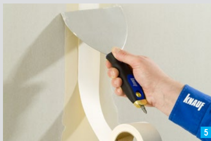
Einlegen des Fugendeckstreifens
