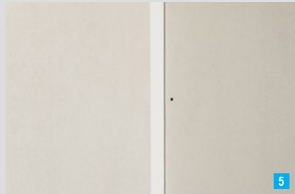
Gipsplatten mit ca. 5 mm Abstand montieren
