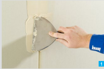
Eindrücken der Spachtelmasse quer zur Fuge
