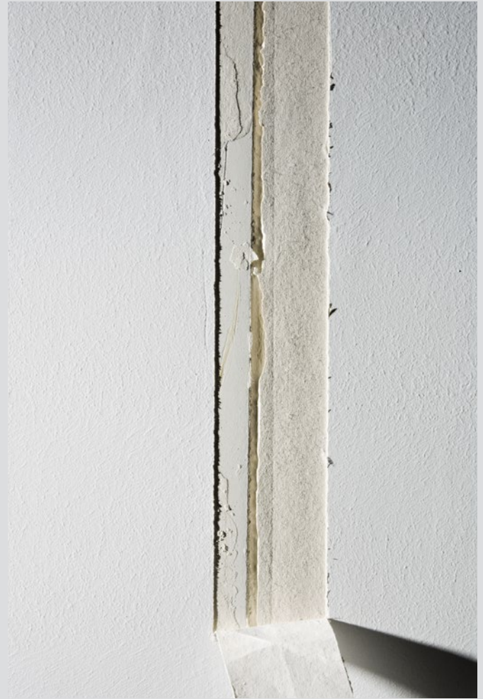
Ursache: zu wenig Spachtelmateriel unter dem Fugendeckstreifen auf der SK-Seite (links der Fugenmitte)
