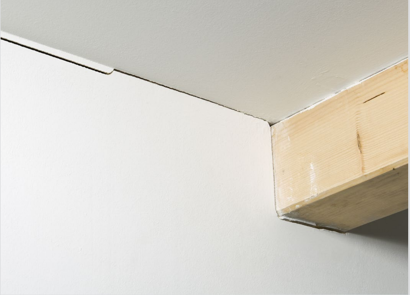
Überspringender Riss aufgrund fehlender Bauteiltrennung
