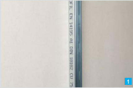
Profil auf angrenzendes Bauteil montieren
