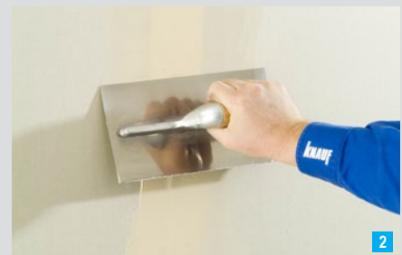
Abziehen in Längsrichtung
