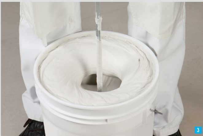
Aufrühren von Knauf Uniflott Finish mit dem Quirl.
