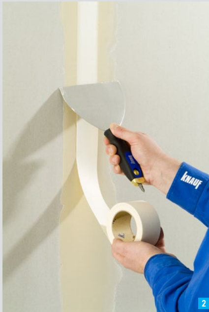
Einlegen des Fugendeckstreifens
