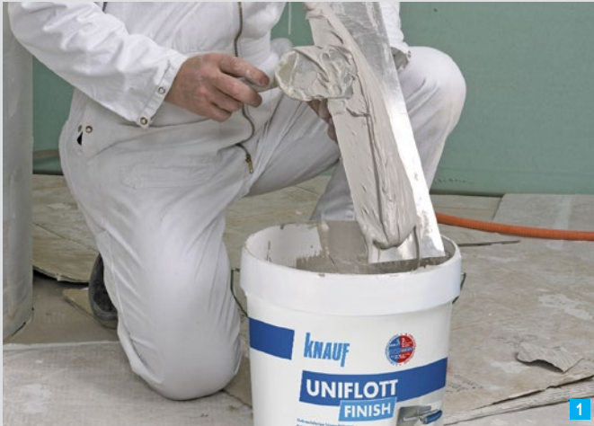
Knauf Uniflott Finish direkt aus dem Eimer entnehmen
