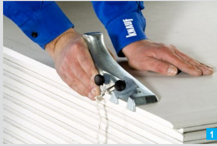
Anfasen einer SFK mit dem Kantenhobel
