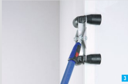
Andrücken der Eckschutzschiene mit dem Ausseneckroller
