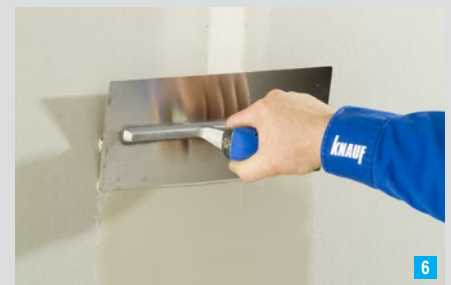
Überspachteln des Fugendeckstreifens
