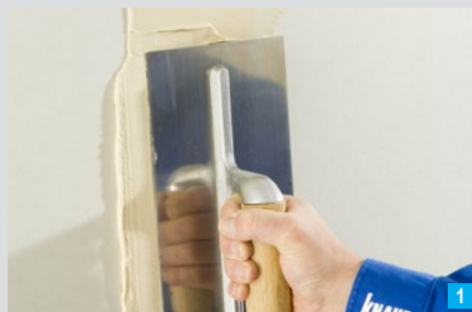
Eindrücken der Spachtelmasse quer zur Fuge
