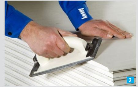
Brechen mit dem Handschleifer bei Knauf Cleaneo-Platten
