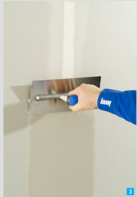
Überspachteln des Fugendeckstreifens mit gebogener Taufel
