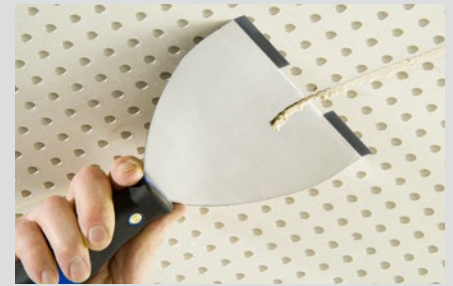
Abstossen von überstehendem Knauf Uniflott nach dem Aussteifen mit der Cleaneo-Spachtel
