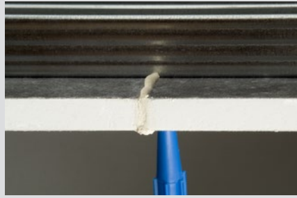
Seitenansicht beim Füllen der Fuge mit Knauf Uniflott
