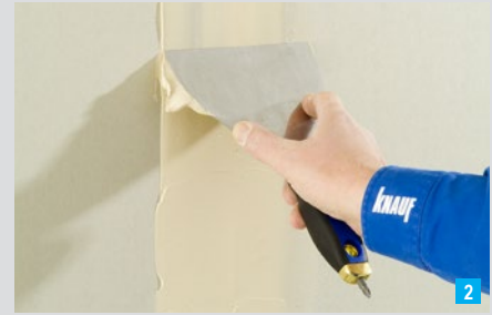
Abziehen in Längsrichtung
