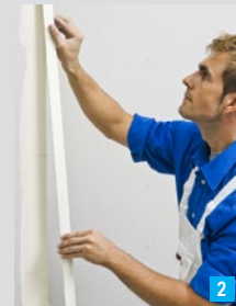
... und einlegen, anschliessend überspachteln
