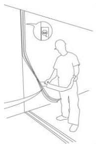
Montage Randdämmstreifen
