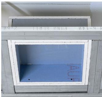
Befestigung der Brandschutzbox an die Unterkonstruktion, allseitig mit jeweils 2 Schnellbauschrauben Typ Knauf XTN Standard 3.9 x 38 mm.
