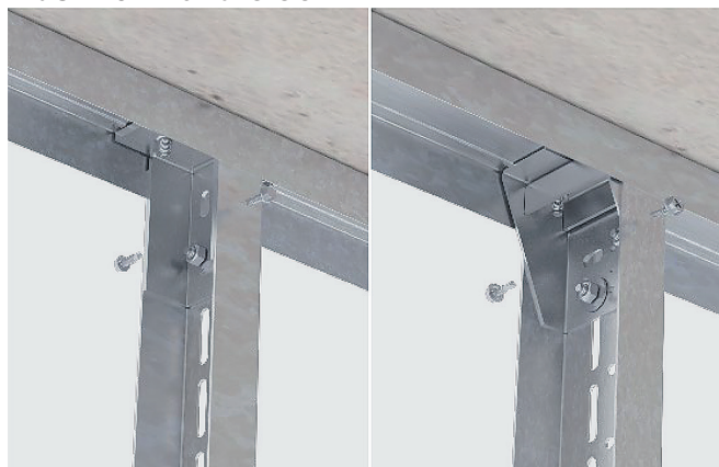
Bild 5: UA-Profil arretieren
