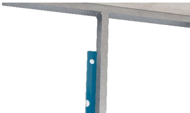
Bild 12: Ausrichten 1. und letzten UA-Profil
