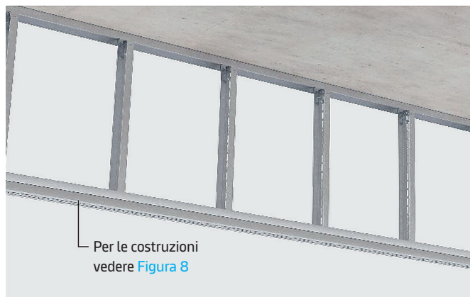
Figura 7: Montaggio della struttura in profili UW per l'estremità inferiore della veletta verticale
