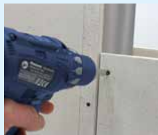
Schrauben auf Metall-Unterkonstruktion
