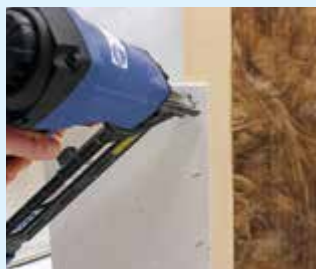
Klammern auf Holz-Unterkonstruktion
