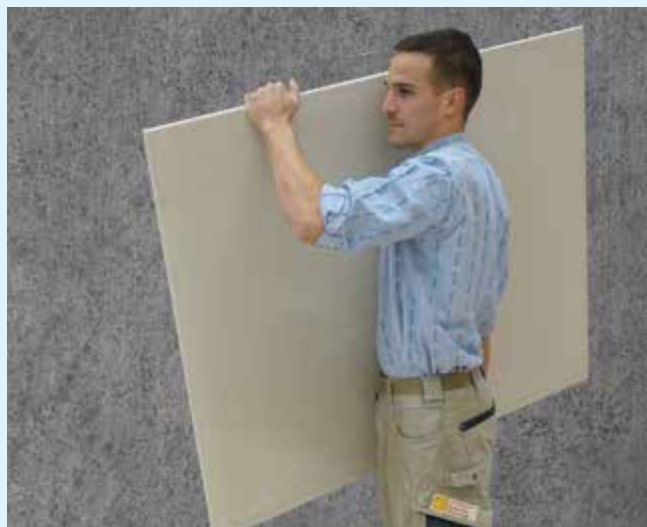
Einzelplatten werden hochkant getragen.
