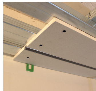
3 vis par largeur d'élément, voir aussi coupe D-D ou A-A.
