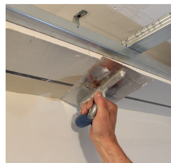
Enduit de surface/enduit de finition: l'application d'un glacis de surfacage constitué par ex. de Knauf Finissimo Universal en qualité de surface Q3 ou Q4 est tout à fait possible.
