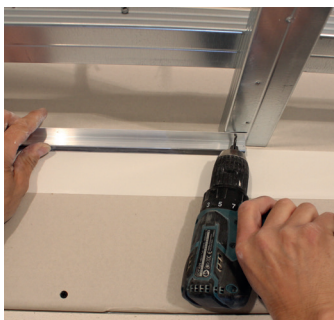
Montage d'un côté, fixation au moyen de rivets à la sous-structure.
