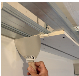
Avant de procéder au montage de nouveaux éléments profilés de base dans la zone de jointure, appliquer Knauf Uniflott.
