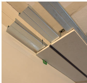
Montage élément profilé de base, distance par rapport au mur 5-8 mm. Raccord au mur au moyen de Trennfix 65.
