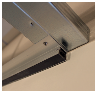
Montage d'un côté à la cloison, fixation au moyen de rivets à la sous-structure.
