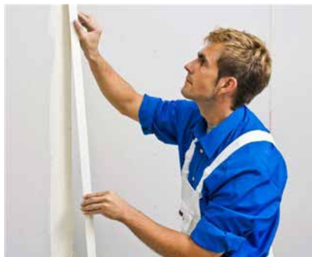
... und einlegen, anschliessend überspachteln.
