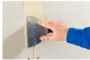
2. Fuge staubfrei machen. Vordem Füllen den offenen Gipskern zur Staubbinding und Saugfähigkeitsregulierung grundieren (z. B. mit Knauf Tiefengrund).
