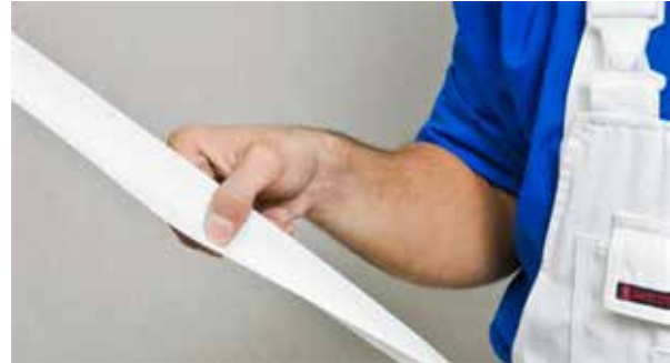
2. Fugendeckstreifen Monti entlang des vorgefertigten Falzes knicken.
