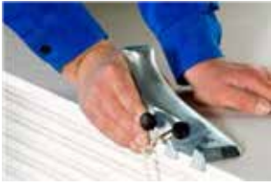
1. An fasen einer SK mit dem Kantenhobel.
