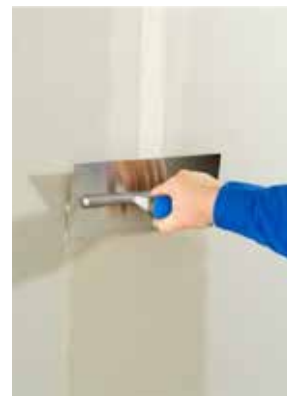
Einlegen des Fugendeckstreifens
