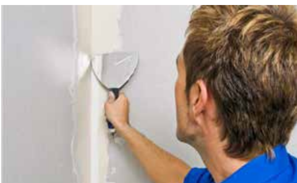
5. Überschüssiges Material entfernen und planeben überspachteln.
