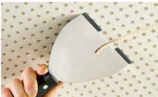
Abstossen von überstehendem Knauf Uniflott nach dem Aussteifen mit der Cleaneo-Spachtel
