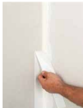
Nach Trocknung und Schleifen Trenn-Fix in der Ecke einschneiden und überstehenden Streifen abziehen
