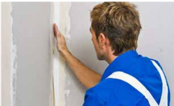
3. Monti mit dem Falz exakt in der Ecke in die Spachtelmassen legen.
