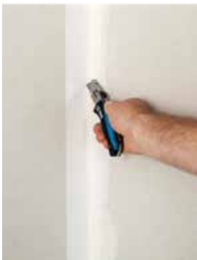
Nach Trocknung und Schleifen Trenn-Fix in der Ecke einschneiden und überstehenden Streifen abziehen
