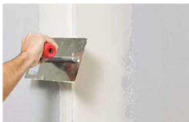
... und einlegen, anschliessend überspachteln.
