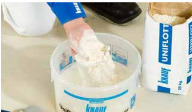
Füllen Sie den sauberen Eimer mit Wasser (Menge nach Herstellerangabe auf dem Gebinde). Streuen Sie das Spachtelmaterial möglichst klumpen frei und gleichmässig auf die Wasseroberfläche.
