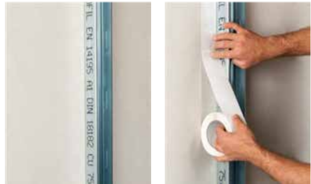
Profil auf angrenzendes Bauteil montieren und Trenn-Fix PRO neben das Profil kleben
