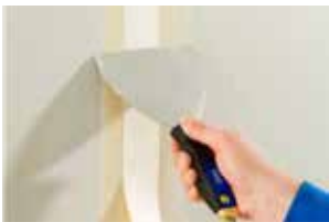
3. Einlegen des Fugendeckstreifens. Mit der Spachtel oder Träufel plan eindrücken sowie überschüssiges Material abziehen.
