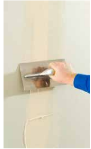
1. Eindrücken der Spachtelmasse quer zur Fuge. Mit Knauf Uniflott ist bei reiner HRAK Fuge kein Fugendeckstreifen nötig.
