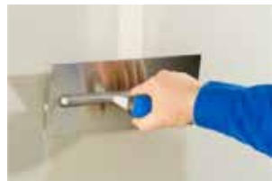
3. Einlegen des Fugendeckstreifens. Mit der Spachtel oder Träufel plan eindrücken sowie überschüssiges Material abziehen.
