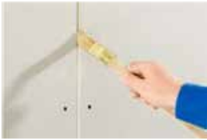
2. Fuge staubfrei machen. Vordem Füllen den offenen Gipskern zur Staubbinding und Saugfähigkeitsregulierung grundieren (z. B. mit Knauf Tiefengrund).
