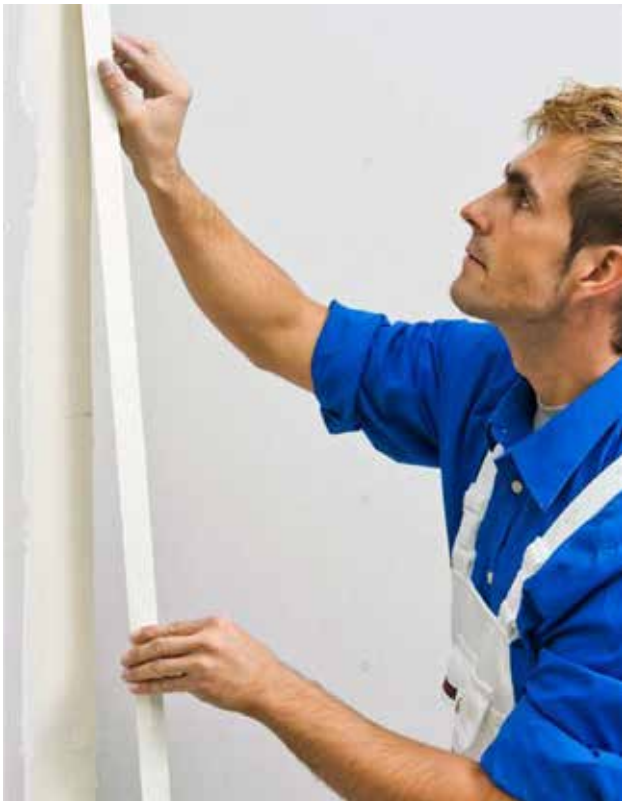
Alux-Kantenschutz einlegen...
