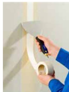
Einlegen des Fugendeckstreifens
