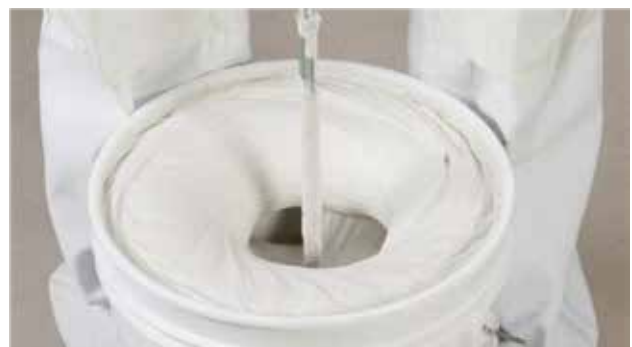
Nach dem Sumpfen wird die Spachtelmasse von Hand oder mit dem Mixer gut durchgerührt, bis sich eine sahnigsteife Konsistenz ergibt. Verwenden Sie beim Quirl grosse Korbdurchmesser bei niedriger Drehzahl.
