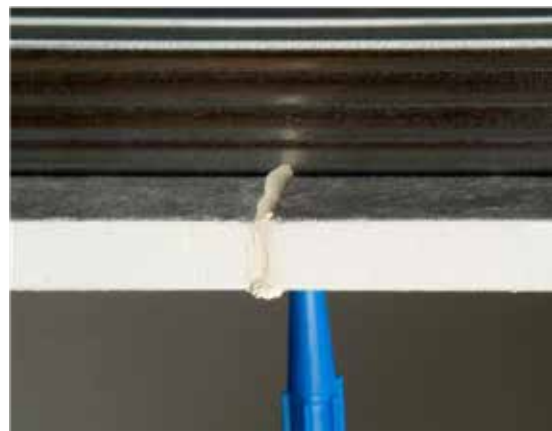
Seitenansicht beim Füllen der Fuge mit Knauf Uniflott
