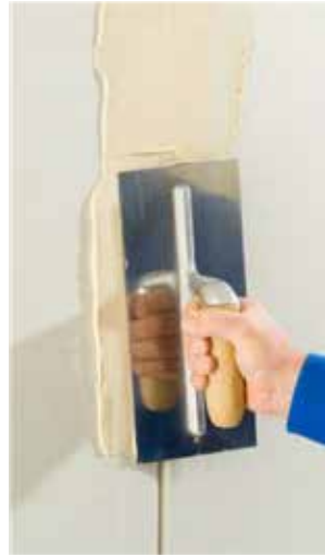
1. Eindrücken der Spachtelmasse quer zur Fuge. Mit Knauf Uniflott ist bei reiner HRAK Fuge kein Fugendeckstreifen nötig.
