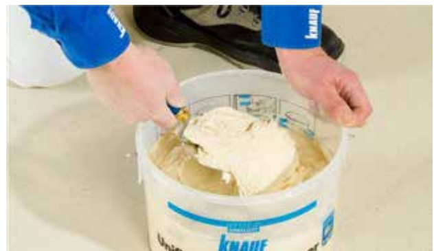
Das Spachtelmassepulver sinkt dabei langsam auf den Eimerboden und saugt sich mit Wasser voll. Diesen Vorgang nennt man Sumpfen.
