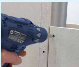
Vis sur sous-construction métallique
