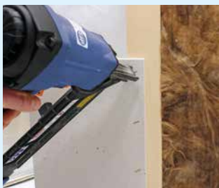
Agrafes sur sous-construction en bois
