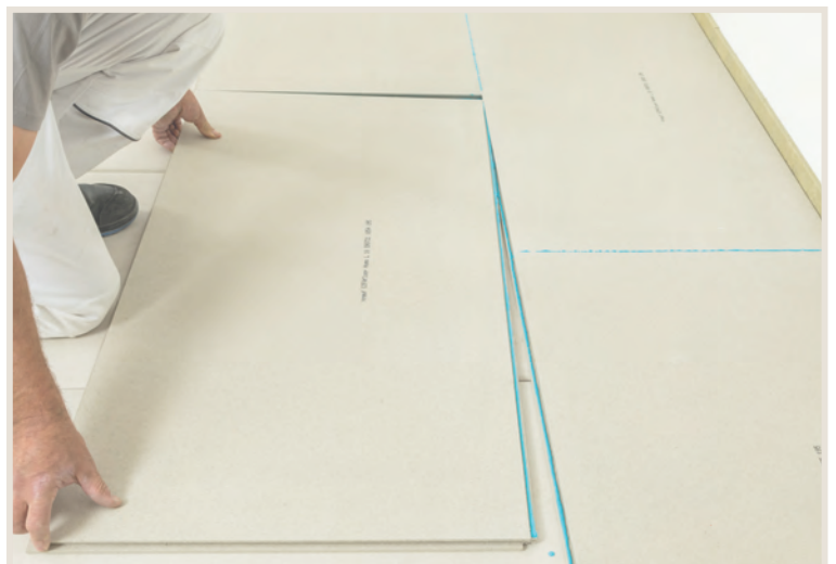
Systemaufbau Knauf Trockenboden-Konstruktion
