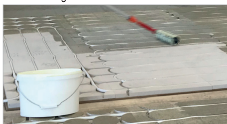
Couche de fond avec le primaire à séchage rapide Knauf Schnellgrund
