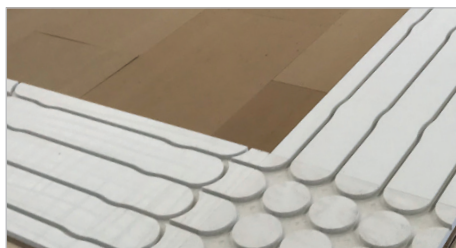
Couche de fond avec le primaire à séchage rapide Knauf Schnellgrund
