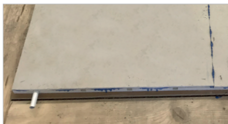
Sol chauffant Brio 25 terminé
