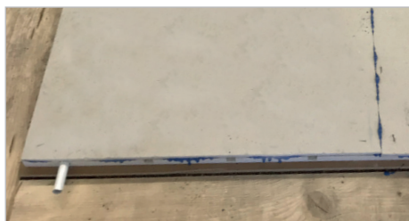
Pavimento radiante Brio 25 finito
