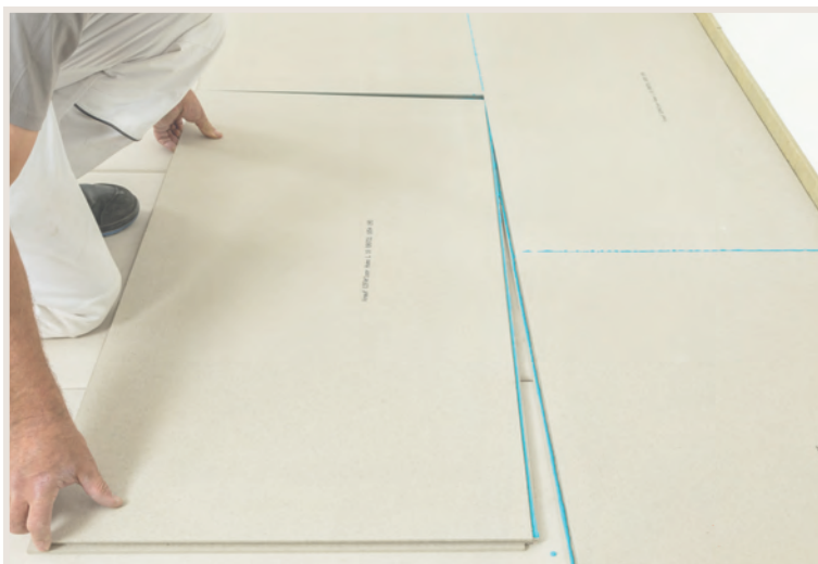
Realizzazione di un pavimento a secco con sistema Knauf
