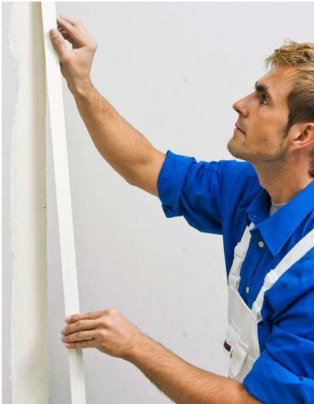
Applicazione del nastro paraspigoli Alux...
