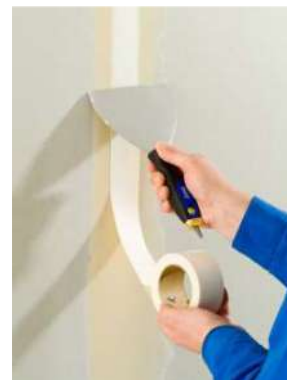
Inserimento del nastro coprigiunto
