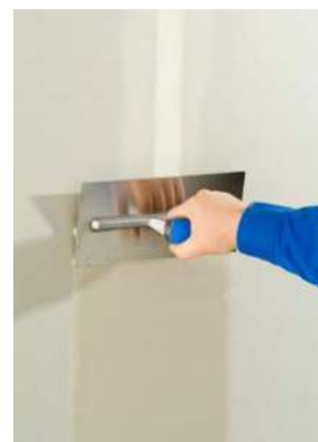
Inserimento del nastro coprigiunto
