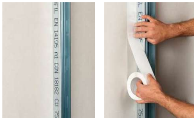
Applicare il profilo all'elemento costruttivo adiacente e incollare Trenn-Fix PRO vicino al profilo stesso.
