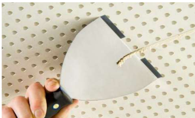
Rimozione dello stucco Knauf Uniflott in eccesso dopo l'indurimento con la spatola Cleaneo
