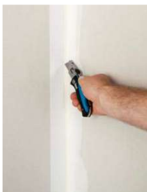
Dopo l'asciugatura e la levigatura, incidere Trenn-Fix nell'angolo e rimuovere il nastro in eccesso.
