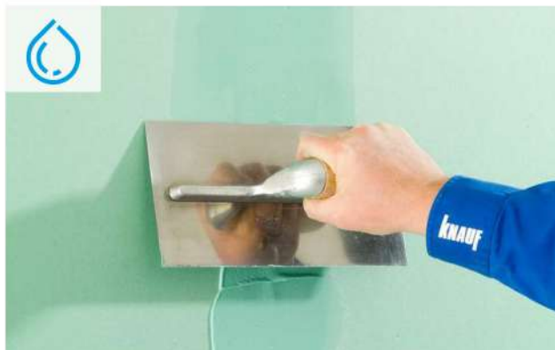
Knauf Uniflott imprägniert per lastre in gesso impregnate (verdi)
