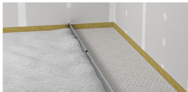
fermacell™ Wabenschüttung einbringen und abziehen
