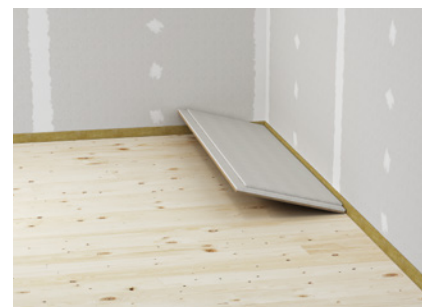
Verlegen der fermacell® Estrichelemente
