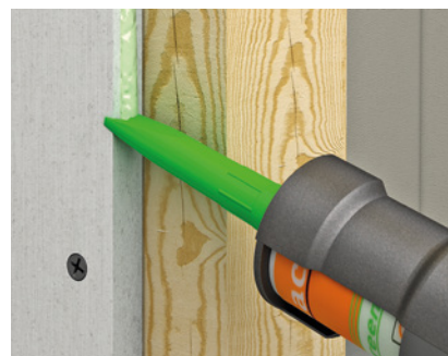
fermacell™ Fugenkleber auf die senkrechten bzw. waagerechten Plattenkanten auftragen.
