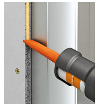
fermacell™ Fugenkleber auf die Plattenkanten auftragen und weiter beplanken.
