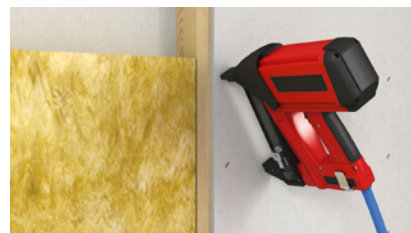
Klammern auf Holzunterkonstruktion
