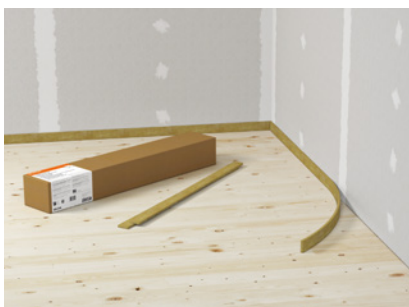
Randdämmstreifen verlegen und in den Ecken stumpf stossen
