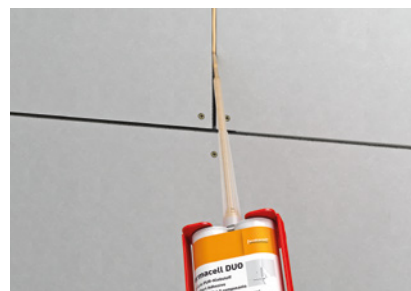
Nachträgliches Verkleben mit fermacell™ DUO Kleber
