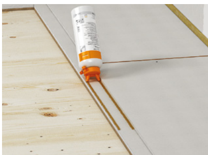
Auftragen des fermacell™ Estrichklebers im Falzbereich
