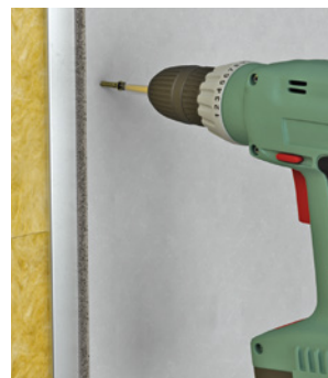
Die Platten mit fermacell™ Powerpanel H 2 O Schnellbauschrauben im Abstand von 20 cm auf der Unterkonstruktion befestigen.
