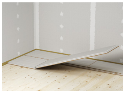
Verkleben der Elemente mit vollständig gefüllten Fugen
