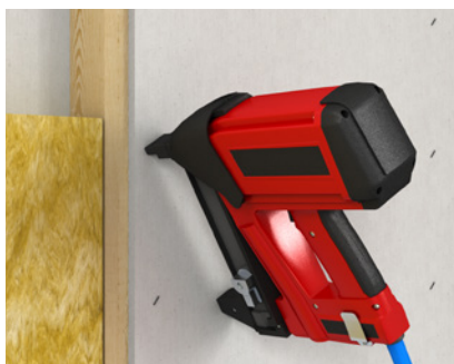
Klammern auf Holz-Unterkonstruktion
