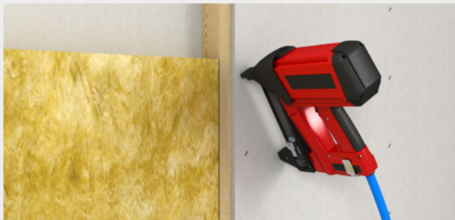
Klammern auf Holz-Unterkonstruktion
