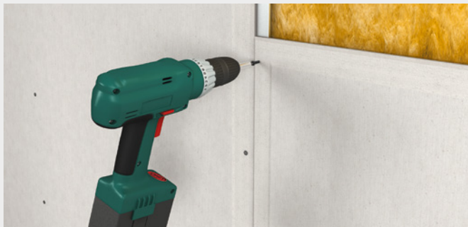
Schrauben auf Stahl-Unterkonstruktion
