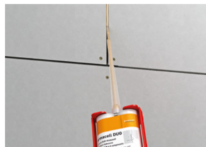
Collage ultérieur avec la colle fermacell™ DUO
