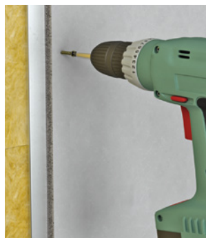
Fixer les plaques avec des vis auto-perceuses fermacell™ Powerpanel tous les 20 cm sur la sous-construction.
