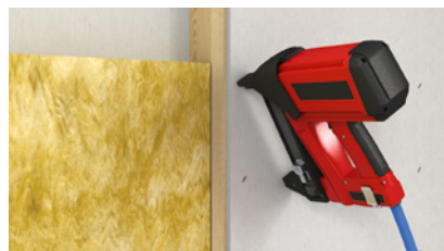
Fixation à l'aide d'agrafes sur une sous-construction en bois
