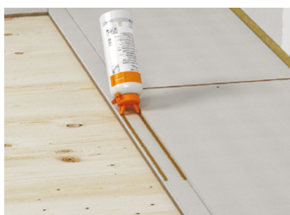
Appliquer la colle pour plaques de sol fermacell™ sur les battues
