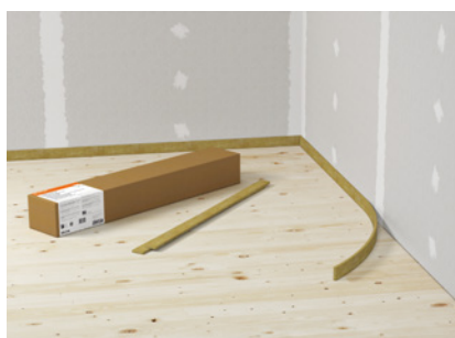
Placer les bandes de rive le long des murs
