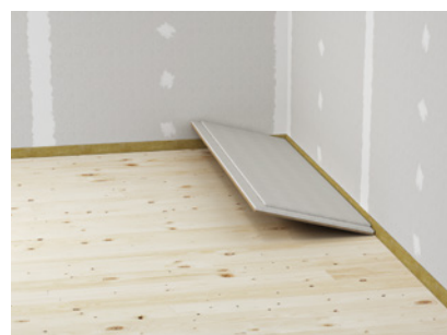
Poser des plaques de sol fermacell®
