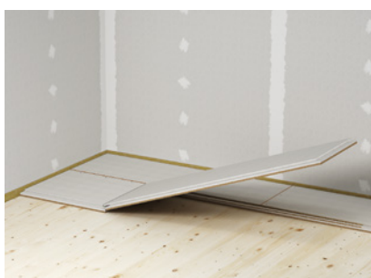
Emboîter les plaques de sol, s'assurer que les joints sont entièrement remplis de colle
