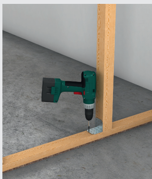
Montage der Holzständer mit Stiftnagel oder Stahlwinkel
