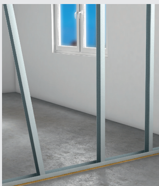
Montage der CW-Ständerprofile
