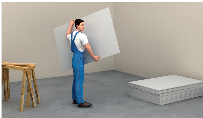
Einzelne fermacell® Gipsfaserplatten hochkant tragen
