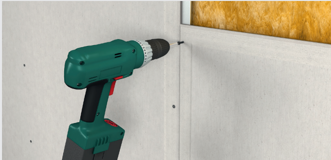
Schrauben auf Stahl-Unterkonstruktion
