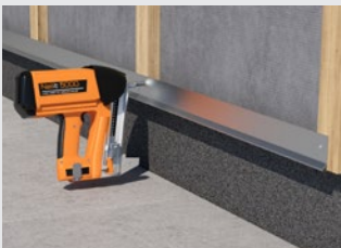
Befestigung des Sockel-Lüftungsprofil.
