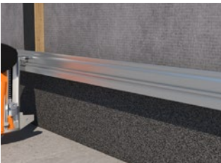
Befestigung des Starterprofils.
