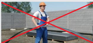
Hardie® VL Plank Platten werden ineinander gesteckt geliefert. Fassadenpaneele sind bei der Entnahme von der Palette seitlich herauszuziehen und erst dann anzuheben.
