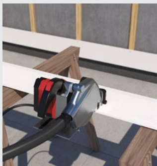
Utilisez une lame de scie adaptée aux produits en fibres-ciment (recommandation : Hardie™ Blade)
