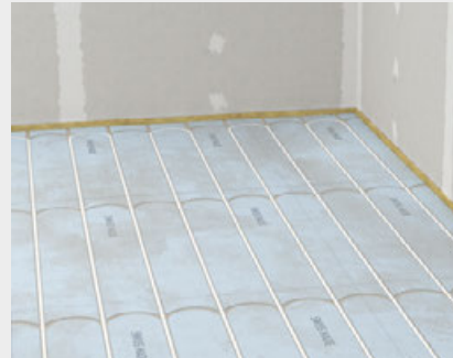
Fertig ausgegossene Therm25™ Elemente (Q1)
