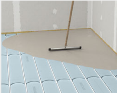
Ausgiessen der Therm25™ Elemente mit fermacell™ Ansetzbinder
