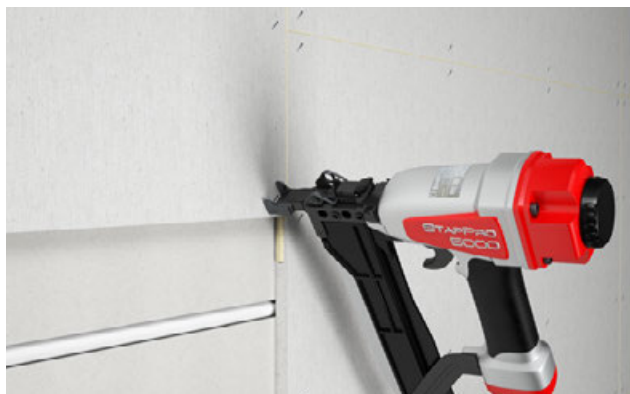
Befestigung zusätzliche Lage fermacell® Gipsfaserplatte oder Powerpanel H 2 O inkl. Fugenausbildung
