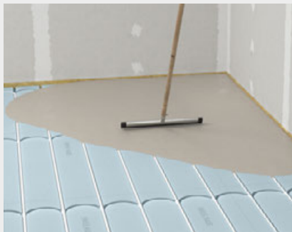
Enduisage des rainures des plaques Therm25™ avec le mortier adhésif fermacell™
