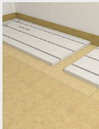
Poser les plaques fermacell® Therm25™ bord à bord en positionnant les joints en croix.
