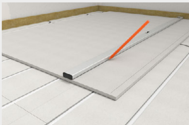
Tracer les axes et les points de fixation ou utiliser un gabarit de fixation, voir la vidéo de pose !
