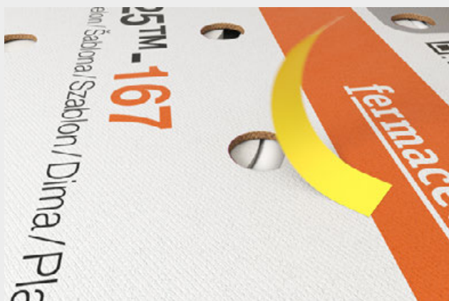
Placer le gabarit sur la zone de pose et recouvrir avec du ruban adhésif les ouvertures dans lesquelles se trouvent les tubes de chauffage.
